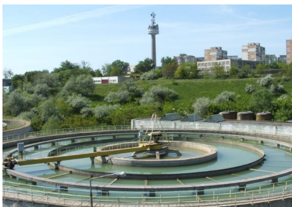
Uzina de apă nr 2-Decantor (foto3)
